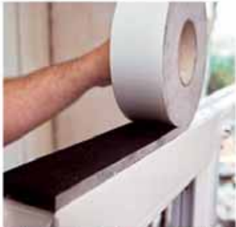
Prikaz nanašanja traku 3 v enem illmod Trio (patentirano)
