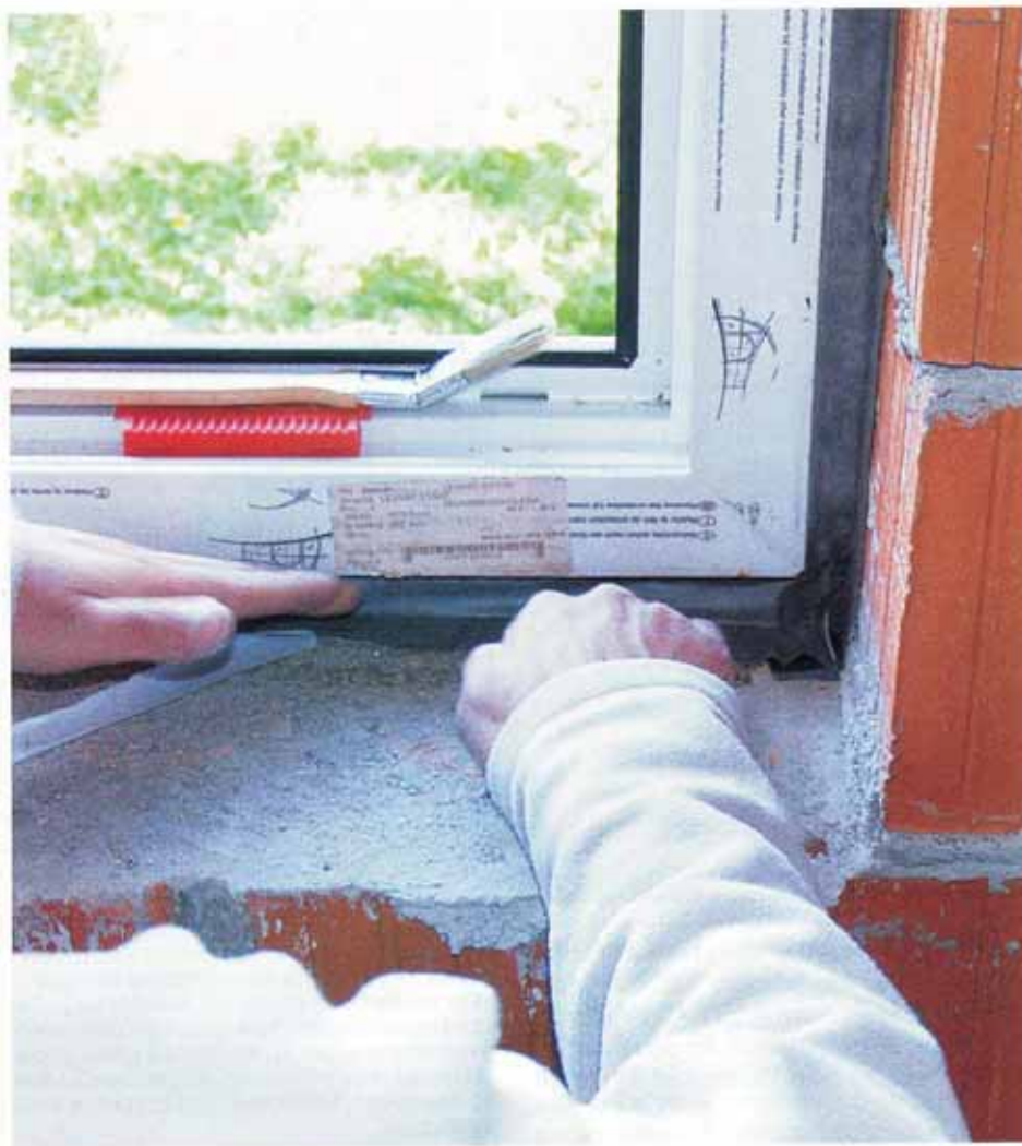
TESNILNO FOLIJO NA SPODNJI STRANI OKEN, NAD PARAPETOM, JE TREBA SPOJITI POD KOTOM 90 STOPINJ, TAKO DA OKENSKA POLICA DOBRO LEŽE NANJO.
